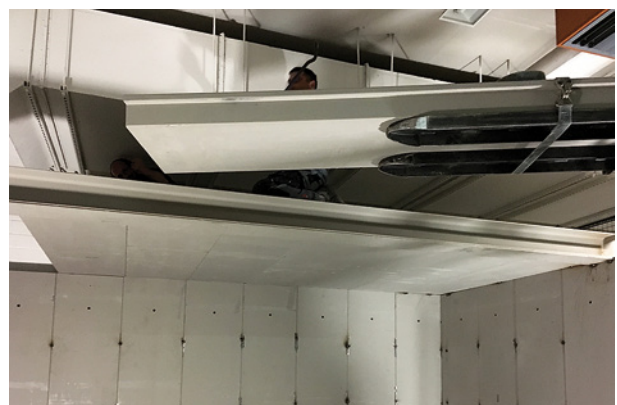
Einbau Deckenelemente
